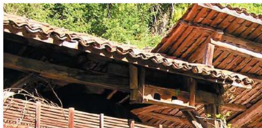
Traitement traditionnel de la rive d'une toiture en tuiles canal
